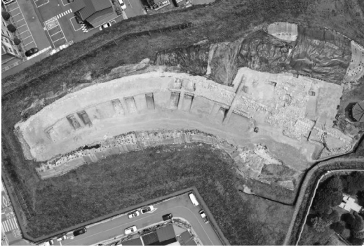
〈그림 9〉 남동벽 구간 성벽 상태
