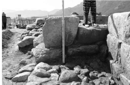
〈그림 6〉 북동벽 구간 치(雉) 상태(직각방향 돌출)
