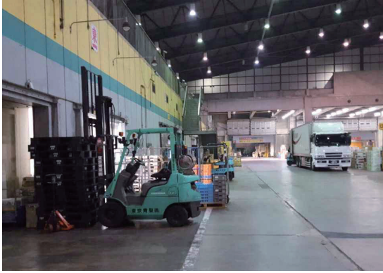
<일본 도쿄 오다도매시장> 법인, 중도매인 활용을 위한 저온보관시설 (경매장내 설치)
