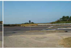
부지 진입부 도로 2
