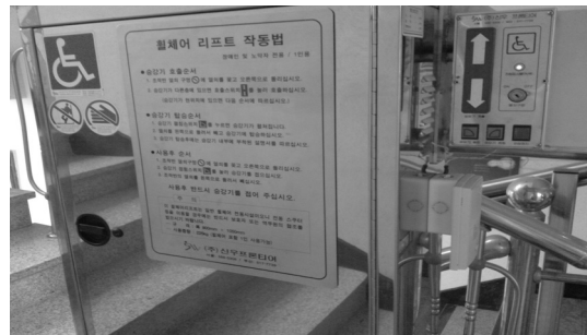
장애인용 리프트가 설치된 건물
