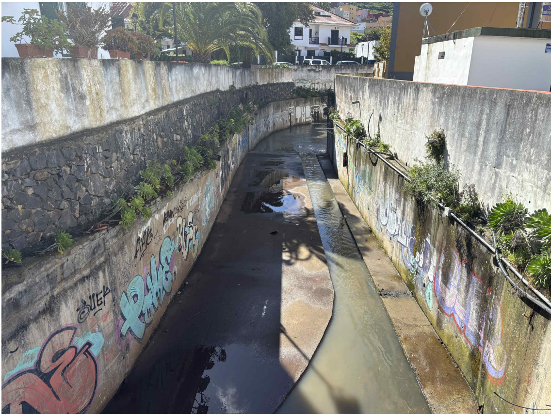
라라구나 소하천(배수로) 전경(정확한 유출량 산정을 위한 정형화된 개수로)
