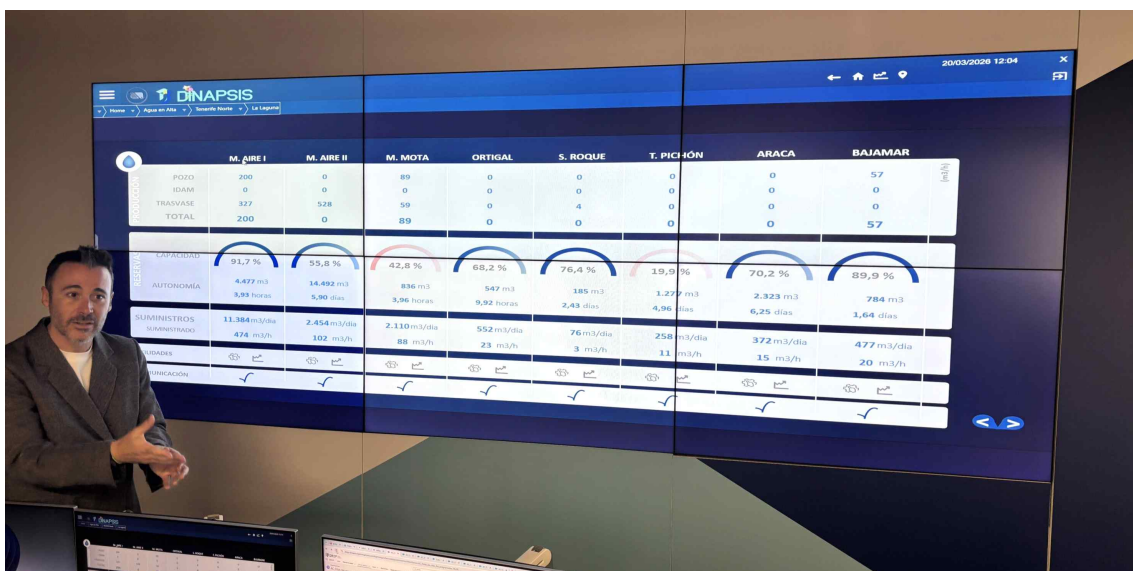
TEIDAGUA 통합관제 화면 및 설명(지역별 상수 공급 현황)
