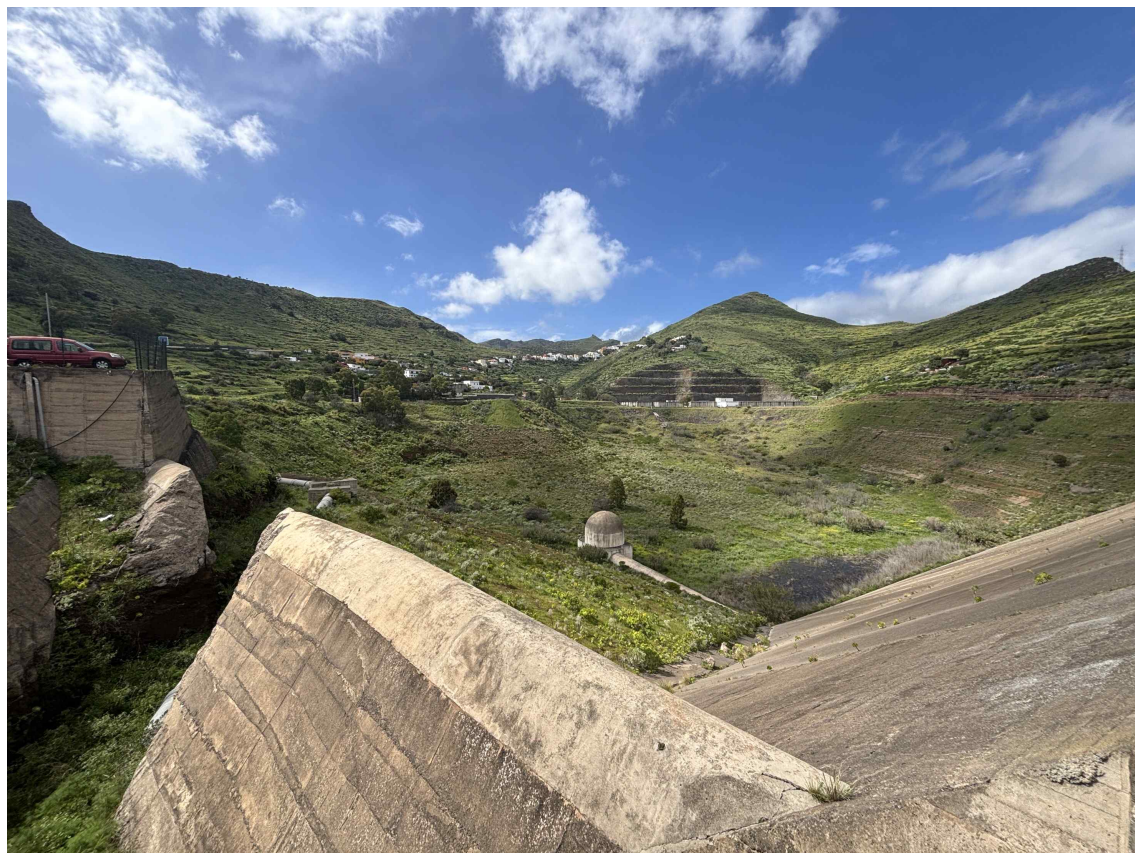
Los Campitos 배수지 전경
