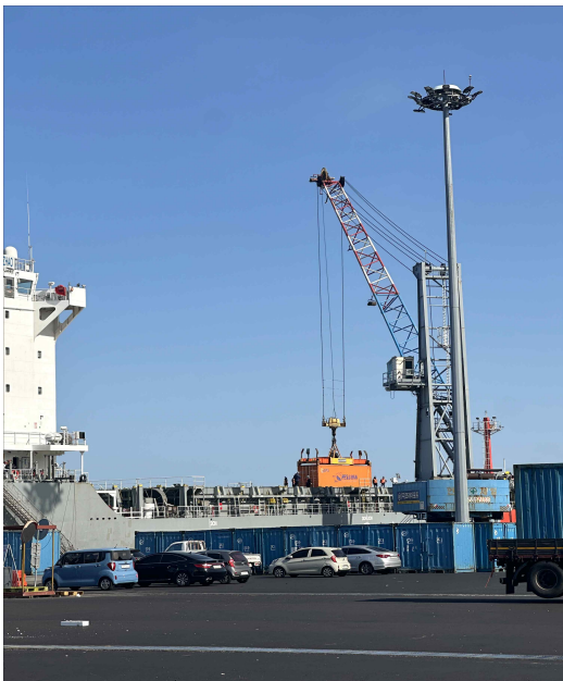
제주항 크레인 및 2선 스프레더
